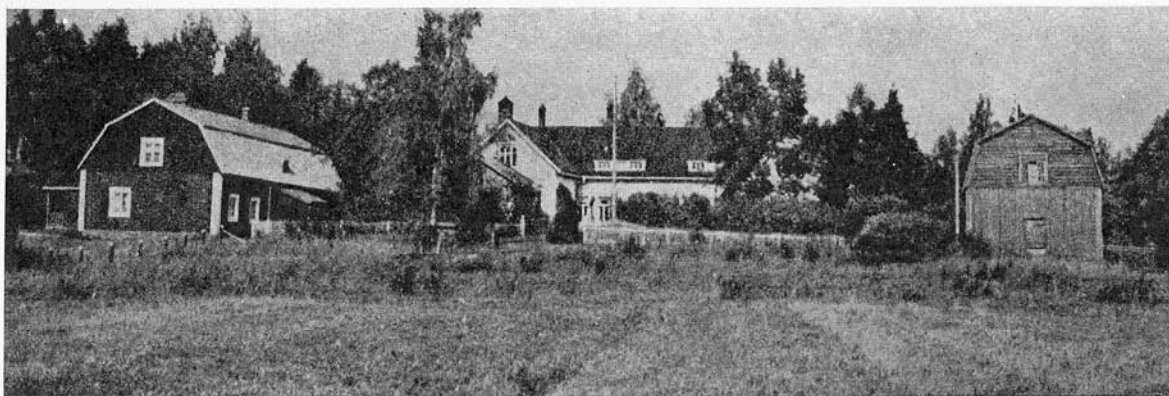
Asuntopiha etelästä päin katsottuna ennen vuonna 1938 suoritettua uusintaa.
