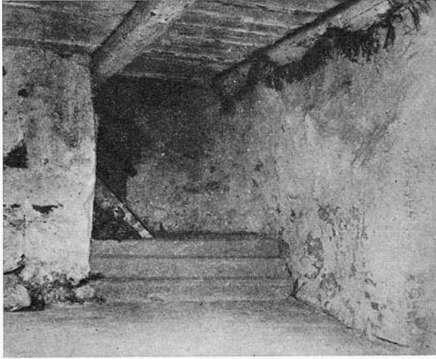
Pohjakerroksen vanha eteinen.
