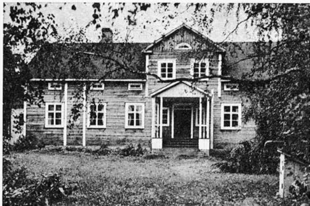
Nykyisen päärakennuksen julkisivu.
