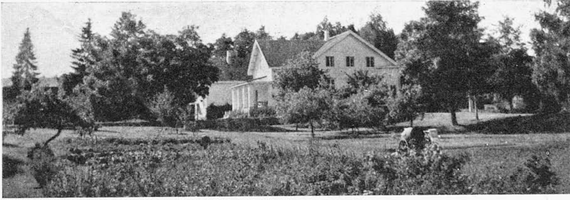
Päärakennus nykyisessä asussaan idästä päin katsottuna.
